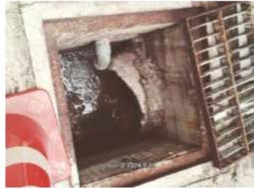
การทำความสะอาดบ่อพักและตะแกรงตีกลุ่มฝอย ภาพที่ 2.2-11 (ต่อ) การบริหารจัดการระบบระบายน้ำ
