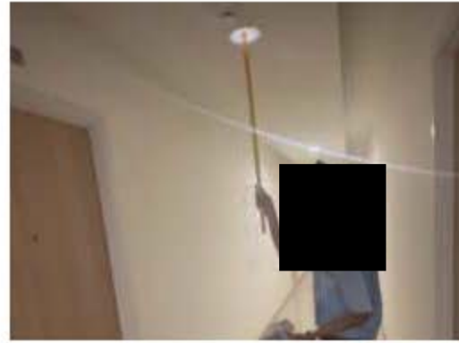
การเปลี่ยนอุปกรณ์ไฟฟ้าส่องสว่าง
