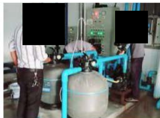
การตรวจสอบระบบกรองสระว่ายน้ำ
